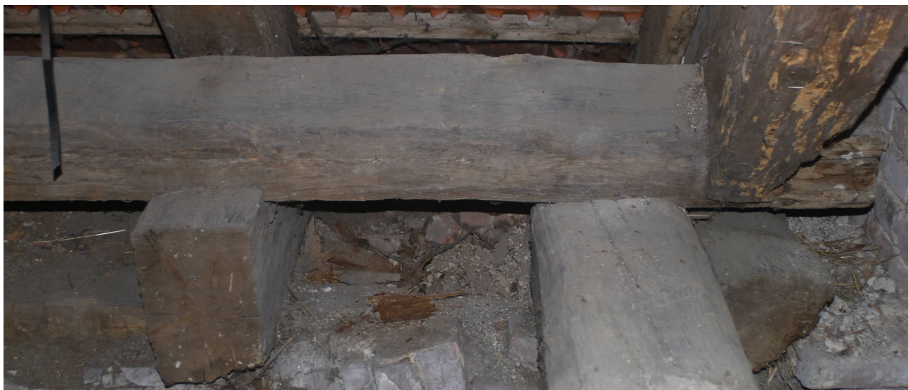
Obr. 10: sonda S5, napadení konioforou, červotočem a tesáříkem
