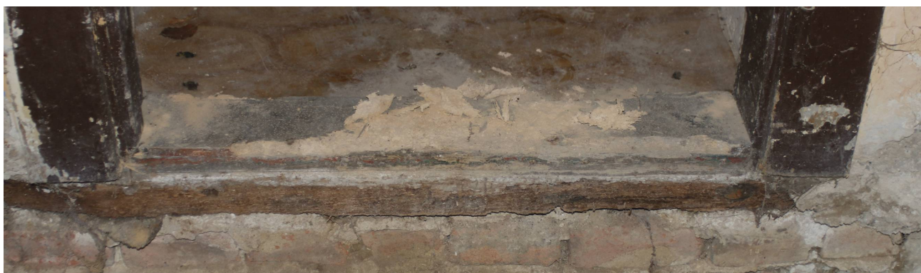
Obr. 7: práh dveří místnost 1.06, destrukce červotočem
