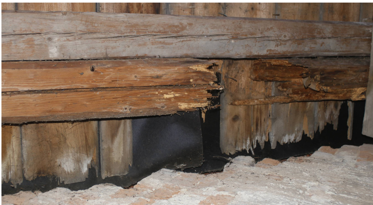
Obr. 9: sonda S4, rozsáhlé napadení konioforou
