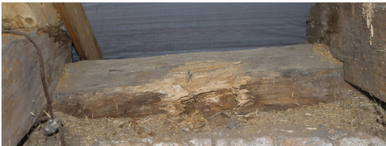
Obr. 13: sonda S8, napadení pozednice
