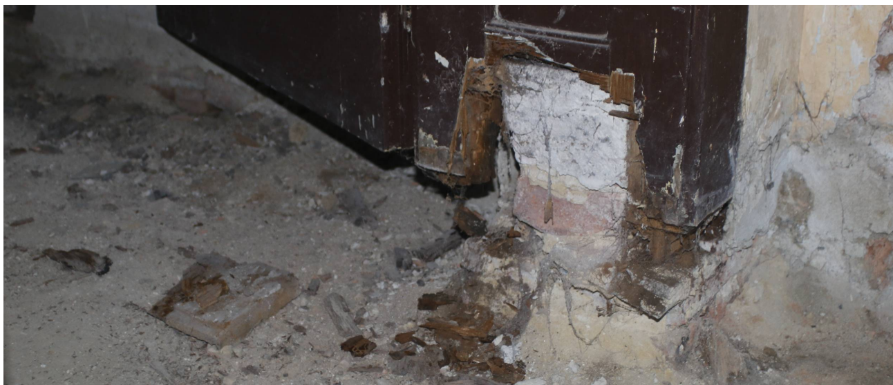
Obr. 6: sonda S2, dřevěné zárubně
