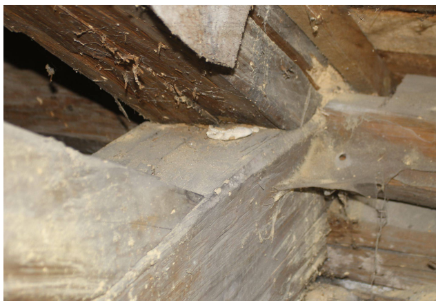
Obr. 8: sonda S3, napadení konioforou
